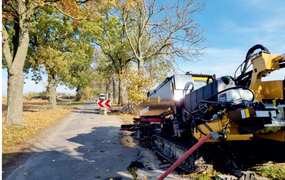
Budowa wodociągu Rostworowo ul. Jesionowa - październik 2021
