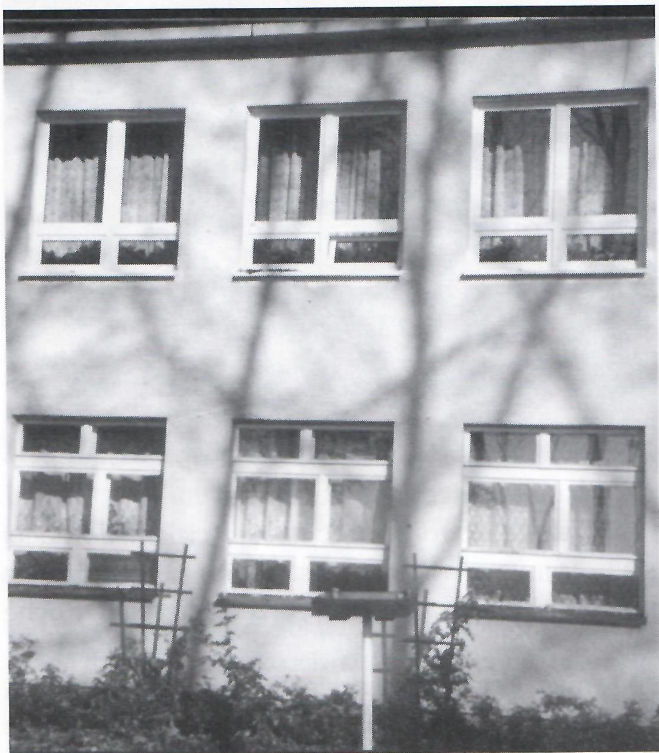
Na zdjęciu: Budynek przedszkola z nowymi oknami.
